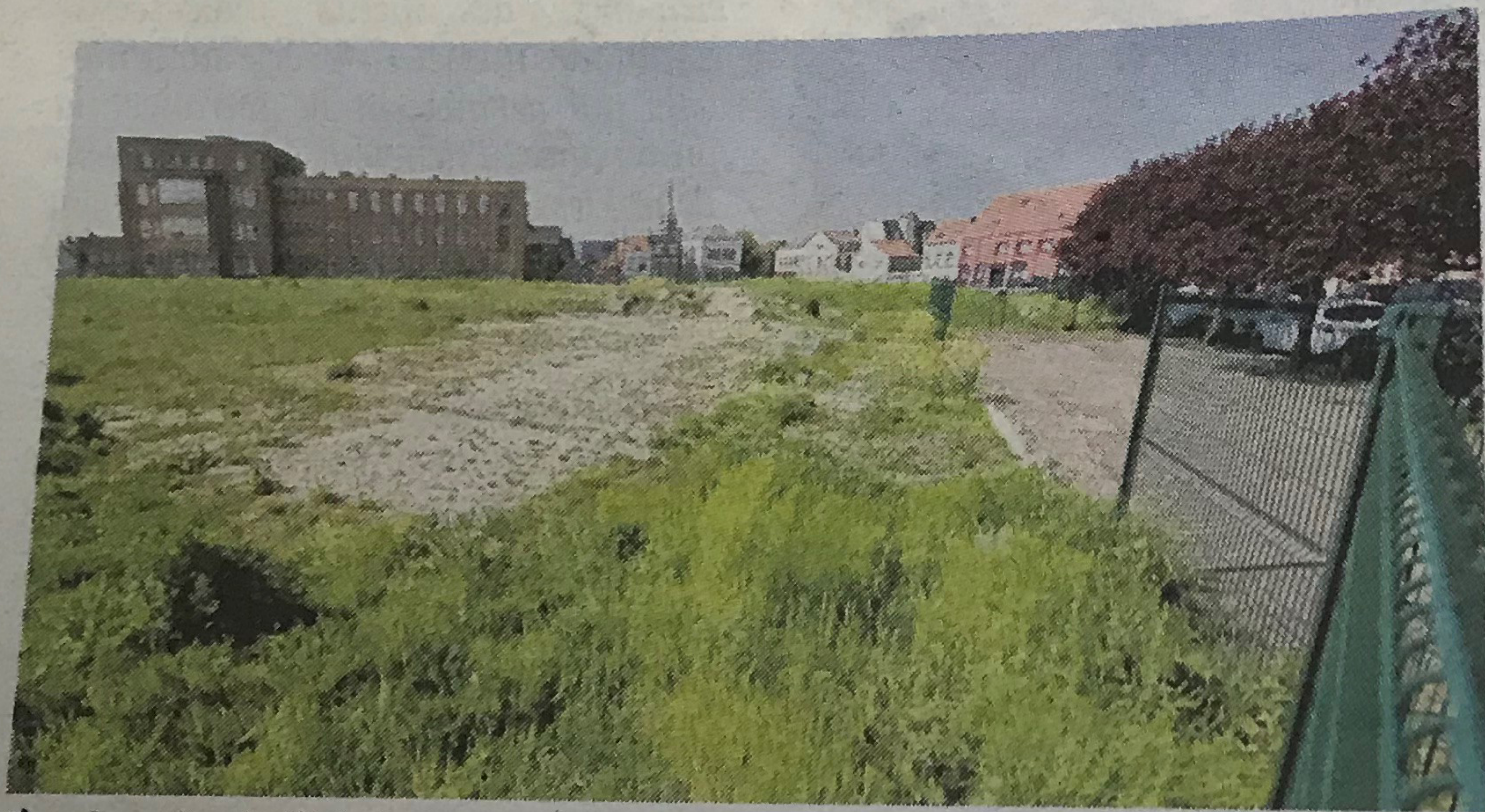
L'ancien site de l'hôpital de Calais, quai du Commerce, accueillera le siège social de l'AFAPEI. PHOTO JOHAN BEN AZZOUZ
